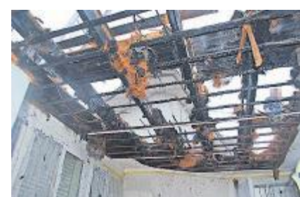
Das Dach wurde gerade saniert. PKS
